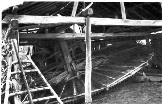
22. ábra Tiprómalom járókorongja (Varsány, Veszprém m., 1910. Foto: Néprajzi Múzeum negatívtára)
