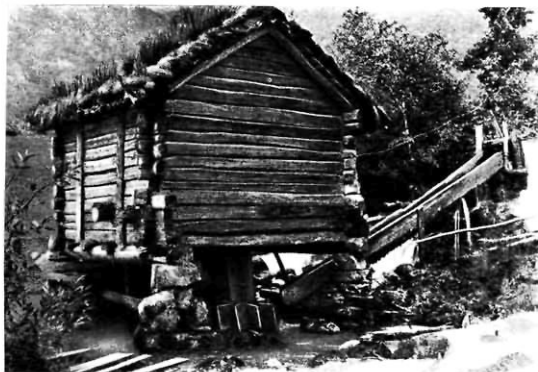
67. ábra Egytengelyes vízimalom (Norvégia)
