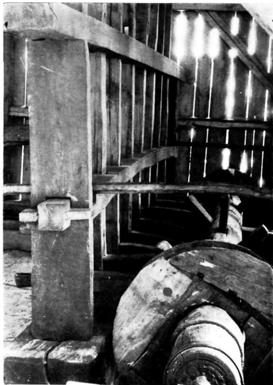
128. ábra Olajütőmalom főtengelye és kalapácsai
