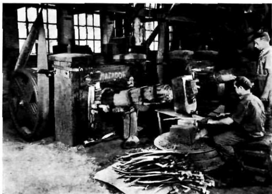
123. ábra Szentgotthárdi Kaszagyár farkkalapácsai
