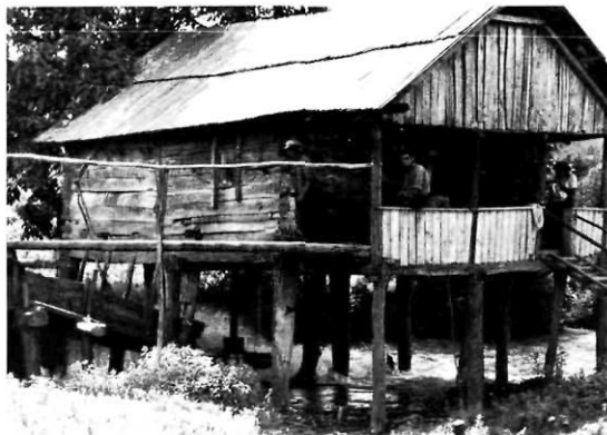
68. ábra. Két kőpárral dolgozó cölöpház, egytengelyű vízimalom (Románia, Arany, 1960.)
