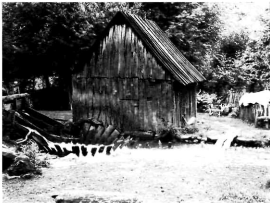
100. ábra Botkalapácsos kallómalom ványolókáddal (Románia, Dobra Sugag, 1960.)
